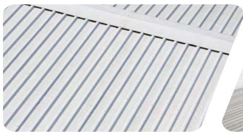
Cobertura metálica com telha trapezoidal
