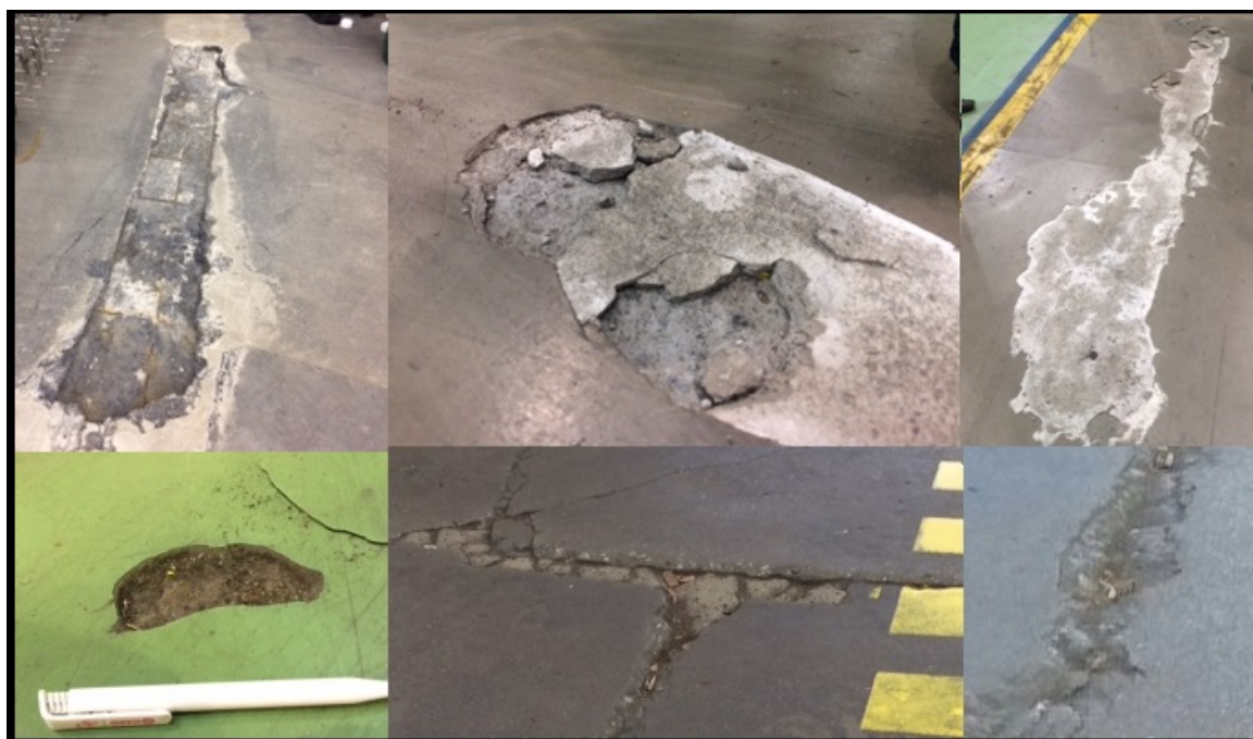
Figura 1 - Exemplos de pisos de concreto que podem ser reparadas com Hard FR 117
